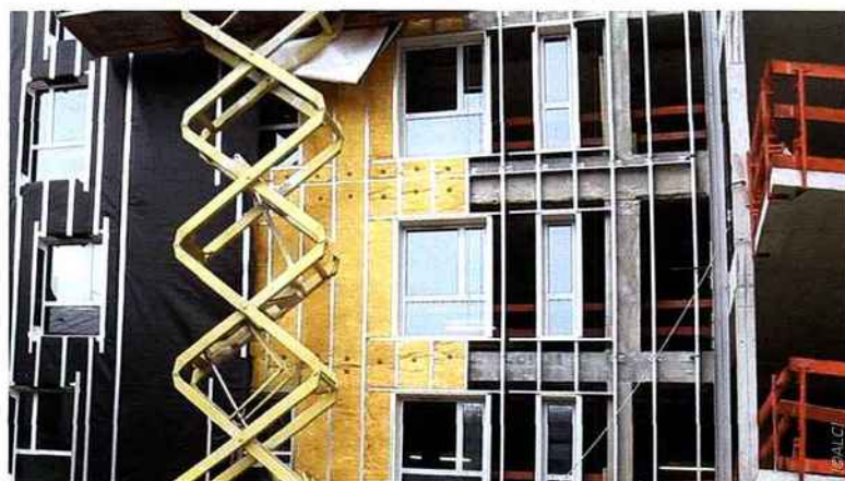
La Façade F4, concept de filière sèche développé par Isover et Placoplatre, unit en un seul système l'isolation par l'intérieur et l'isolation par l'extérieur.
